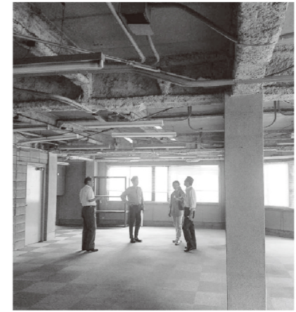
改修前の1階部分
